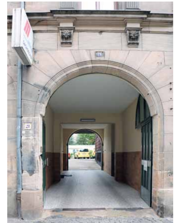
Durch diese schmale Einfahrt pressen sich täglich rund zehn Baustellenfahrzeuge.
